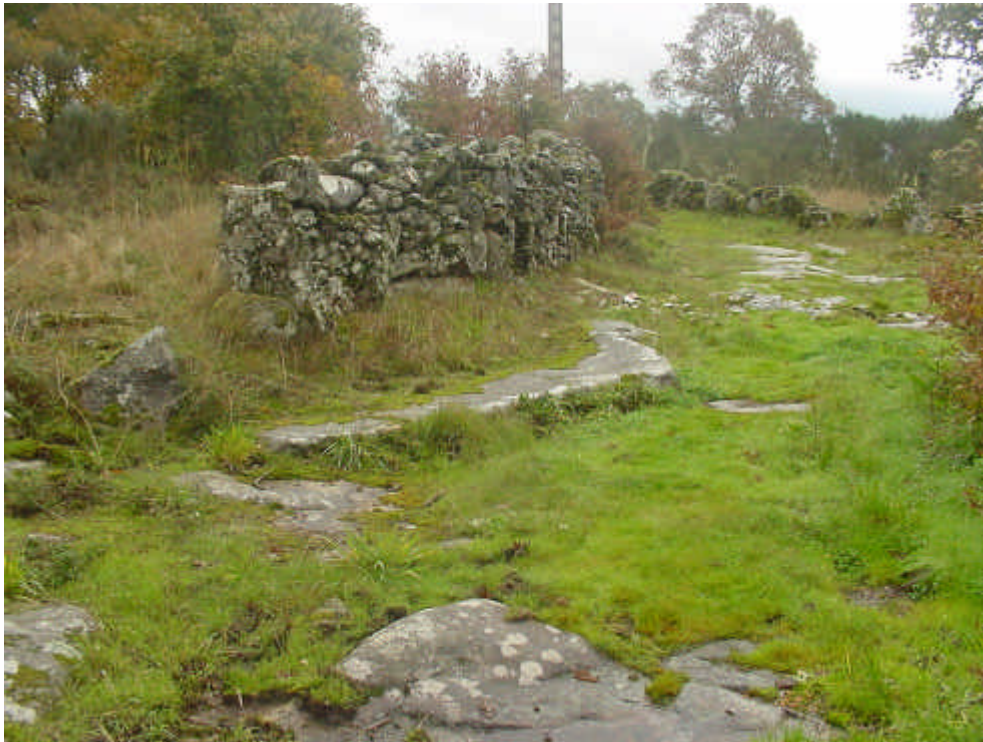
Segundo os veciños a tampa atopábase sobre este muro do lugar das Muradellas
